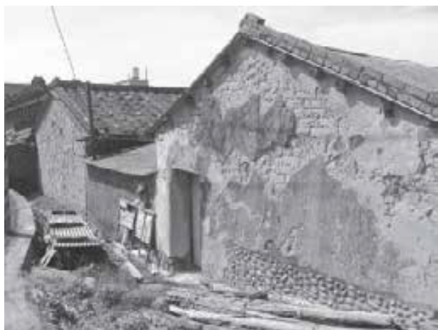
图5：房屋侧边等用石头上用夯土建筑完成表现先民开拓台湾时使用当地的物资建造安身立命的栖身之所
